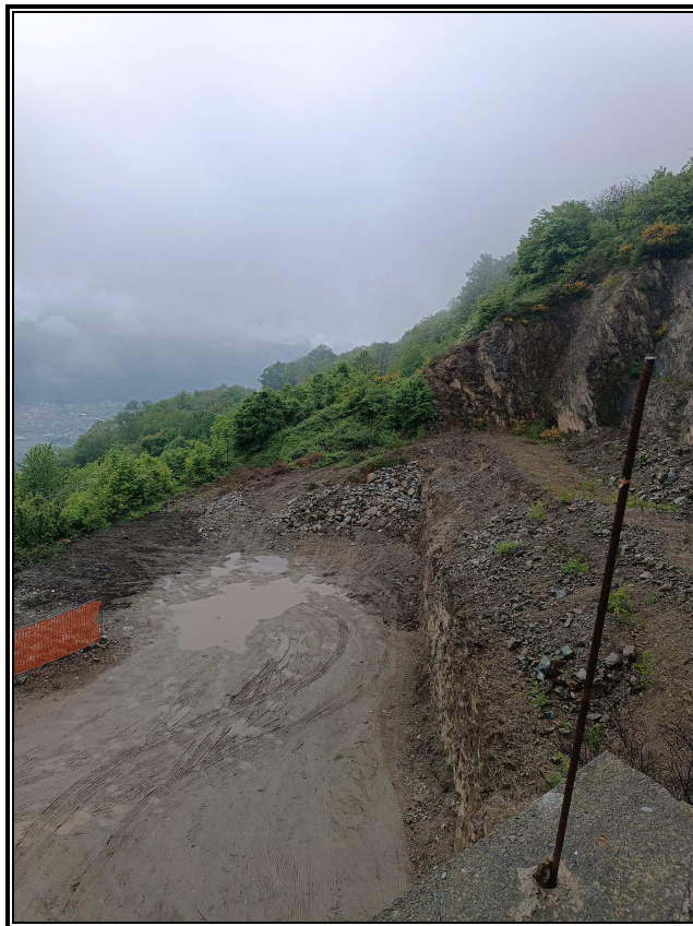
Foto 1: Vista est dell'area oggetto dei lavori
